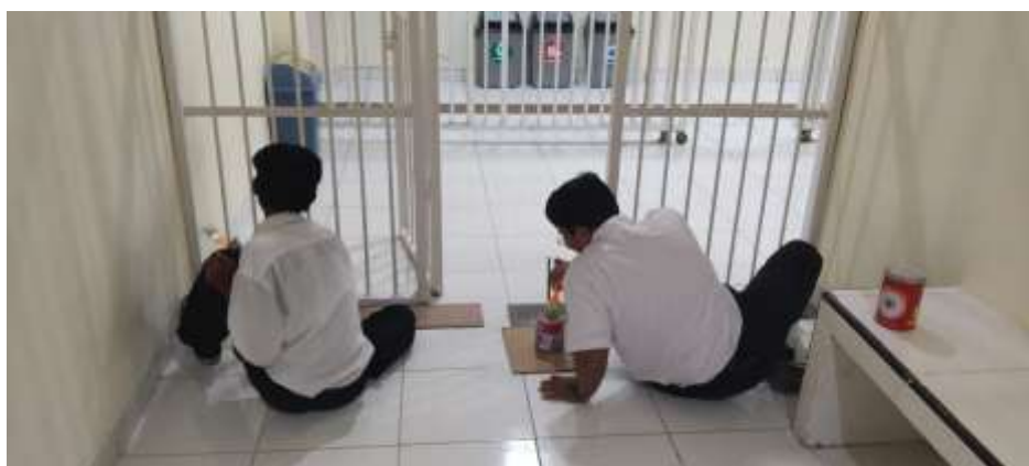
Dokumentasi foto pengecatan ruang tahanan
