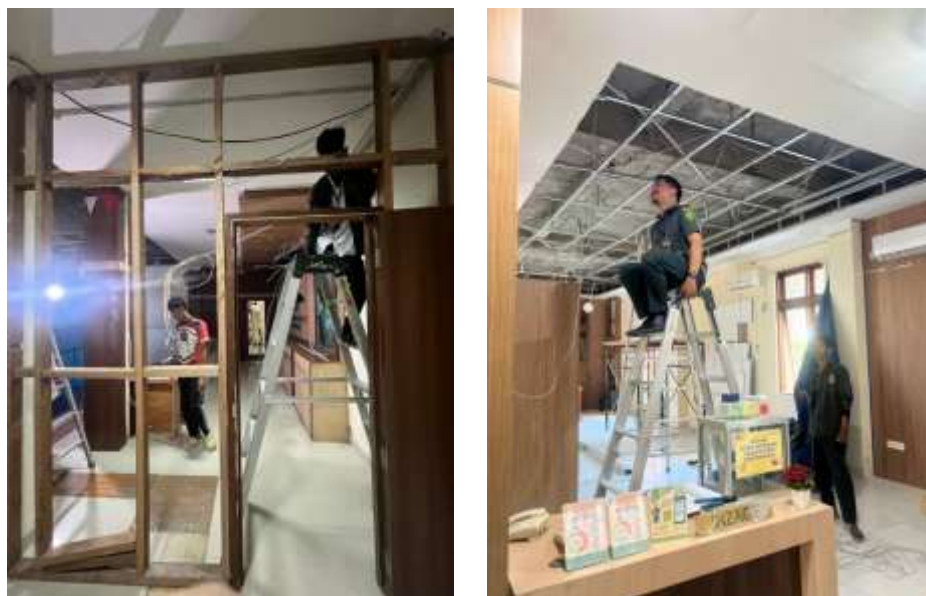
Foto Dokumentasi pengerjaan Pelebaran PTSP
